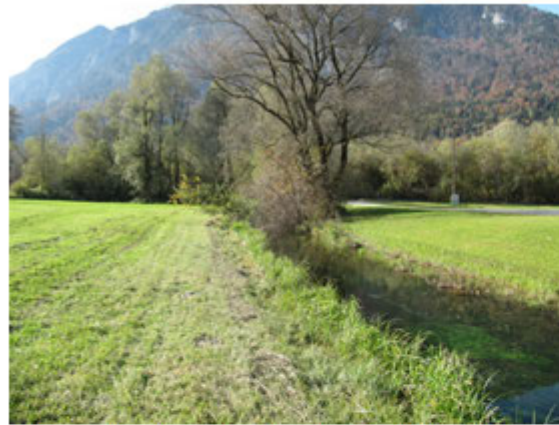
Giessenbach im Norden des Projektgebietes, östl. der Bahn
